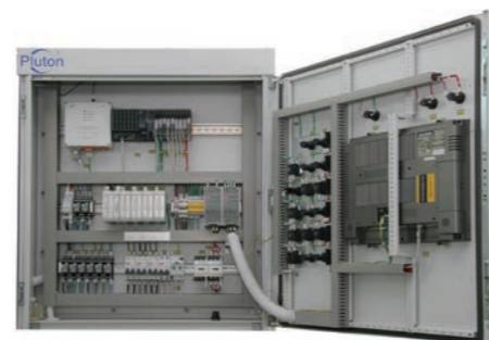
Отсек управления распределительного устройства серии РУ-3,3к
