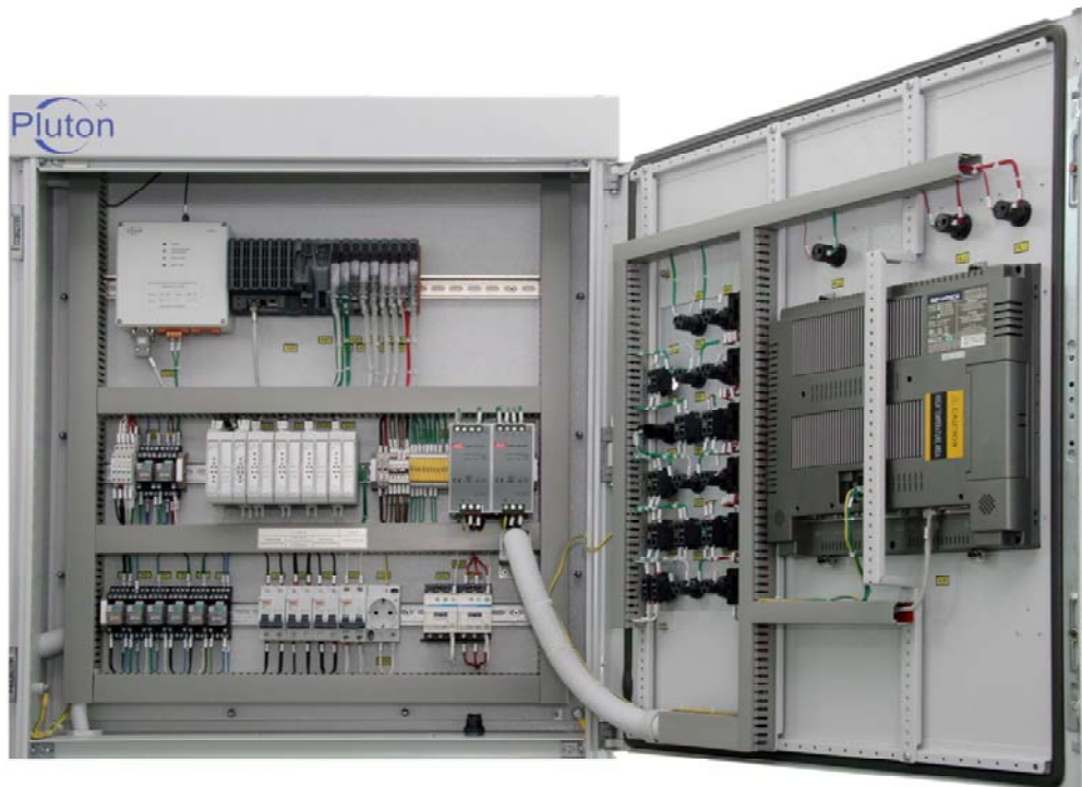
Отсек управления распределительного устройства РУ-3,3к
